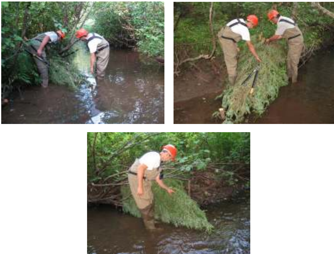
Figure 4 : Installation d'arbres déflecteurs au ruisseau Sewell.
