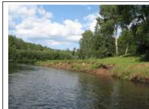
Érosion sur le bord d'une rivière
