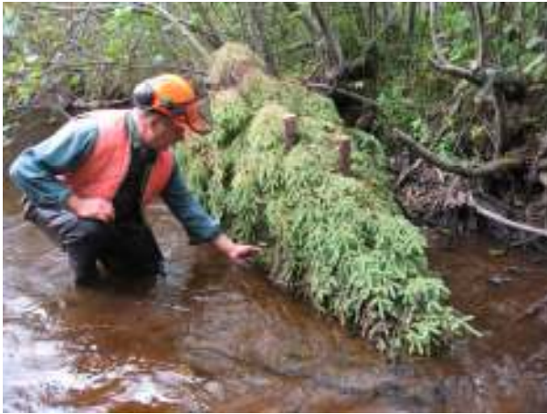
Figure 13. Accumulation de limon à la base d'un déflecteur.
