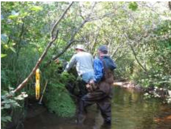
Figure 11. Explications de la méthode d'installation des déflecteurs au ruisseau McConnell, par Terry Melanson, de Pêches et Océans Canada.
