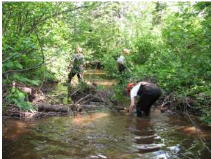
Figure 7 : Embâcle causé par un arbre tombé à travers du ruisseau avant et après le nettoyage sélectif.
