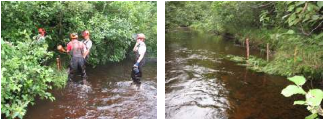
Figure 19 : Installation de déflecteurs dans le ruisseau McConnell
